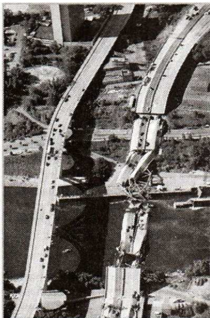
Коррозия в сочетании с ошибками в конструкции привели к разрушению моста через реку Миссисипи в штате Миннесота (США) в августе 2007 года.
